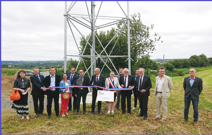
L'antenne de Penn ar Prat Kerc'honan, en service depuis le mois de juillet, est un des derniers pylônes installés en Finistère.
