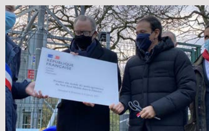
À Botmeur, le secrétaire d'État au Numérique Cédric O a inauguré la première antenne 4G multi-opérateurs installée en Finistère dans le cadre du New Deal Mobile.
